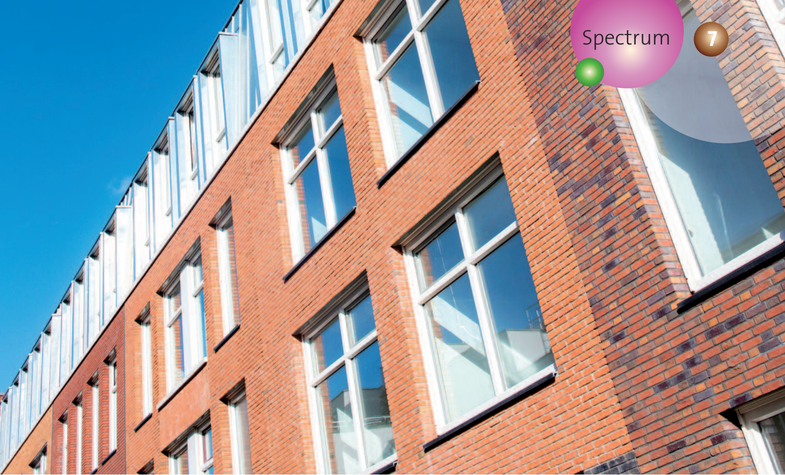
WZH Vliethof in Voorburg wordt in september 2019 opgeleverd.
